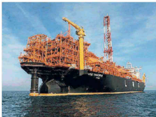
Il terminal off shore di Lng Toscana
