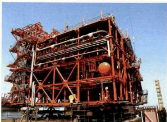
Il modulo di rigassificazione nel settembre 2010, prima dell'imbarco sul terminal FSRU Toscana nel corso dei lavori di trasformazione effettuati a Dubai (per g.c. OLT).
