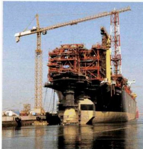
Il terminale FSRU Toscana nella fase finale dei lavori di trasformazione effettuati a Dubai (per g.c. OLT – photo of Oleksandr Kalinichenko).
