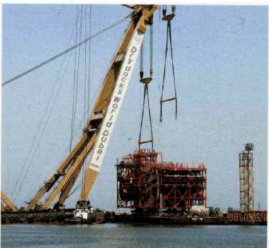
L'imbarco del modulo di rigassificazione del terminal FSRU Toscana nel corso dei lavori di trasformazione effettuati a Dubai (per g.c. OLT).
