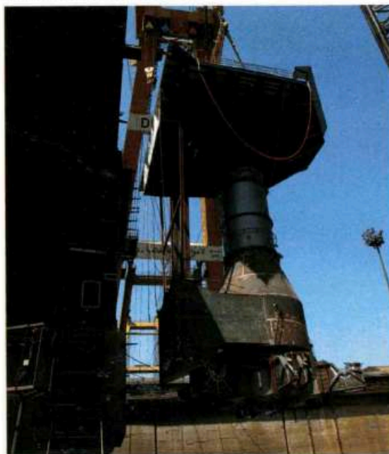
L'inserimento a prora dell'ex nave metaniera GOLAR FROST della torretta di ancoraggio; immagine ripresa il 5 giugno 2010 nel corso dei lavori di trasformazione in terminal FSRU effettuati a Dubai presso il cantiere Drydocks World (per g.c. OLT).
