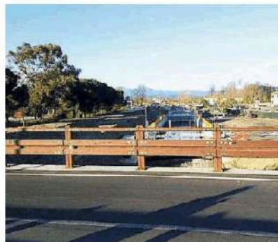
Il nuovo ponte di via Livornese
